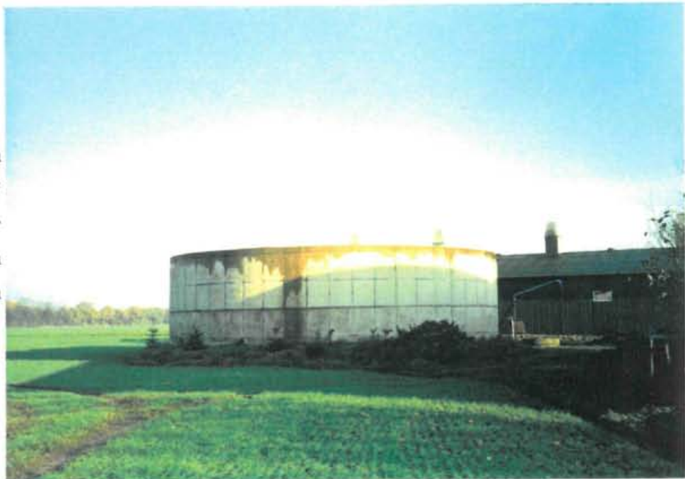
Bild 3: Blick in Richtung Nordosten auf den Güllebehälter. Der Behälter ist durch eine Betondecke nach oben abgeschlossen.
